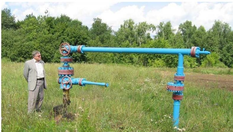
**Рис. 4.4.5 Конструкция скважины нагнетательного типа**
